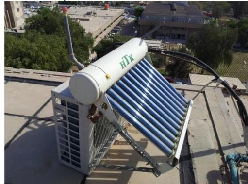
شكل (5) منظومة التبريد الهجينة مع التحويل
