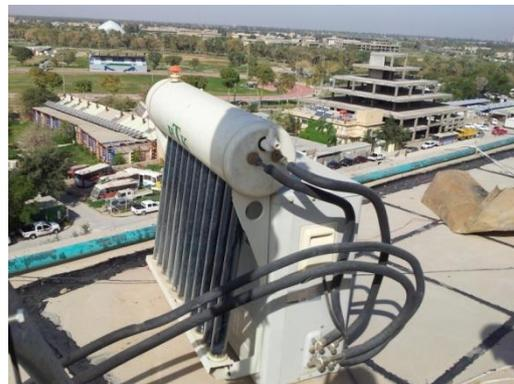
شكل (6) منظومة التبريد الهجينة من دون التحويل
