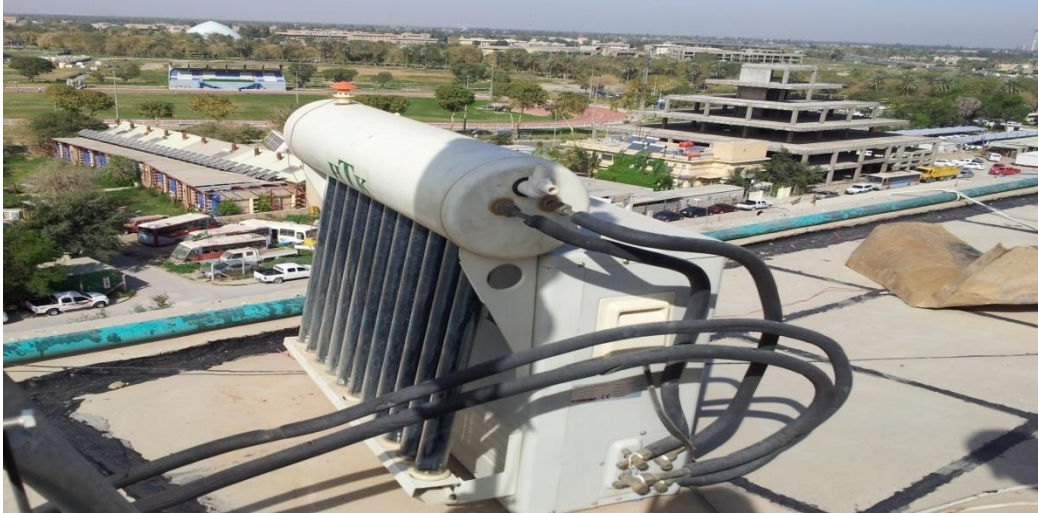
شكل ( 5 ) يبين القطعة الخارجية لمنظومة التبريد الهجينة
